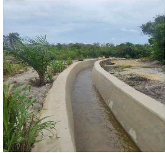
Pembangunan Irigasi Sawah Tanjung Rusa
