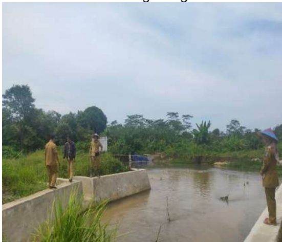
Pembuatan Bangunan Pelimpah dan Saluran Irigasi Sawah Dusun Mentigi
