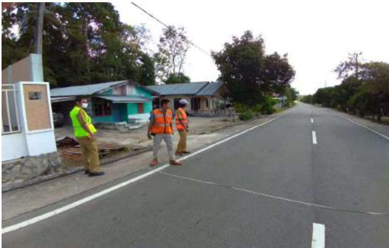
Ket : Pengukuran Lebar Perkerasan
